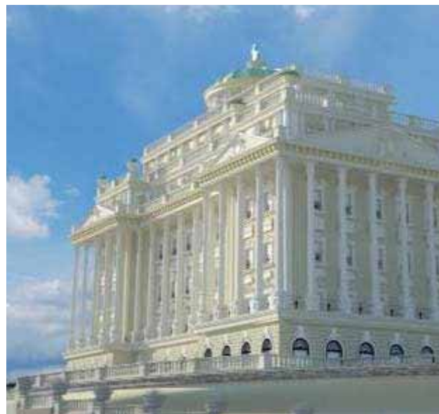
L'impressionnante architecture néoclassique du Sofitel Tirana Palace
